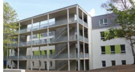
Wohnanlage Nordhäuser Straße 79 in Erfurt
