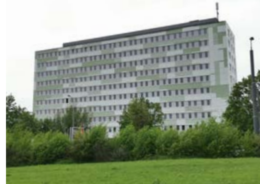
Wohnanlage Nordhäuser Straße 78 in Erfurt
